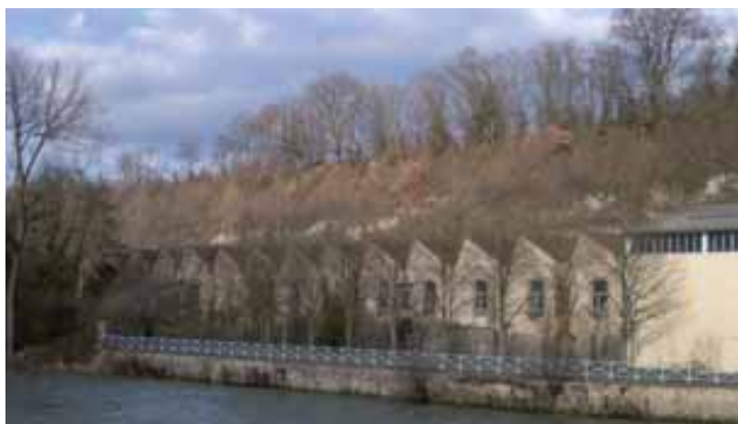
Valentigney, locaux industriels sur les rives du Doubs
